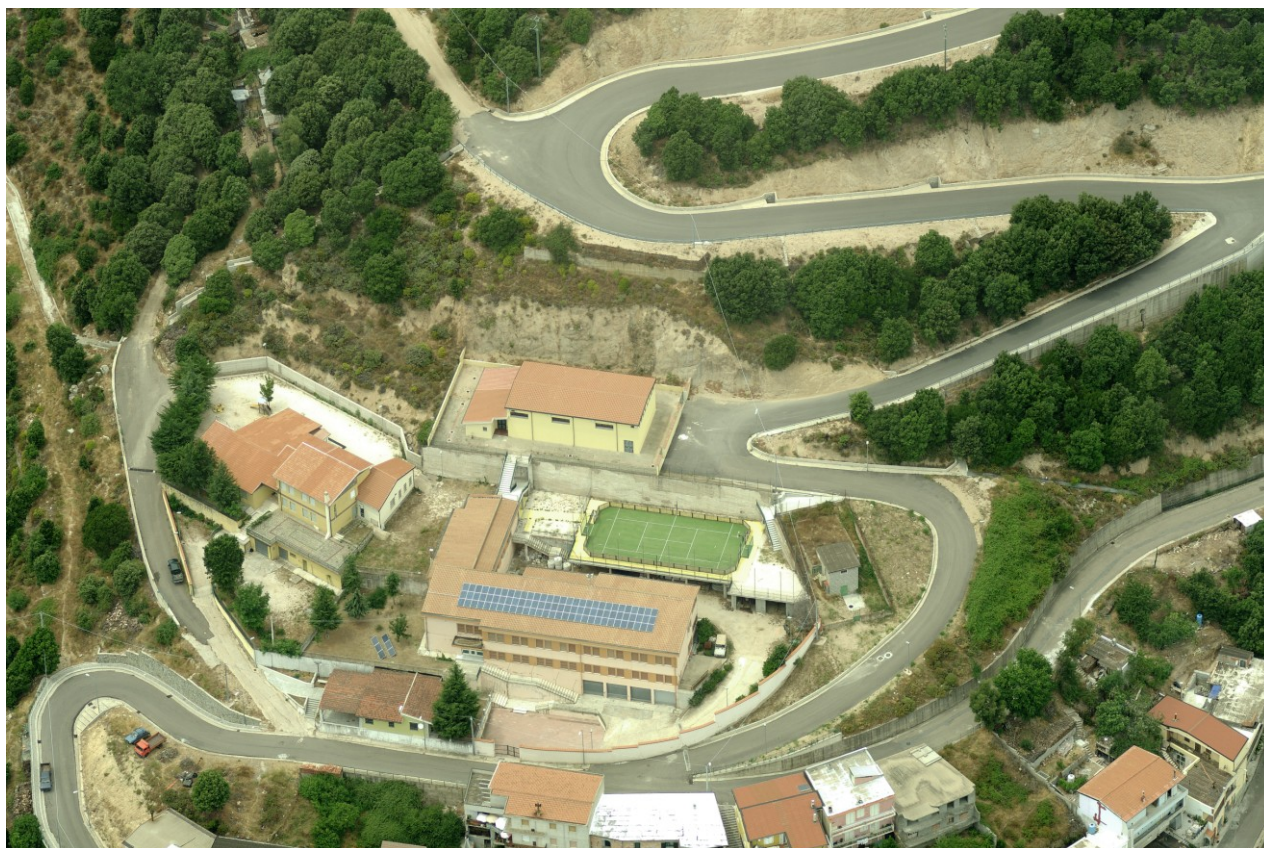
Vista aerea a 45° Edifici scolastici
